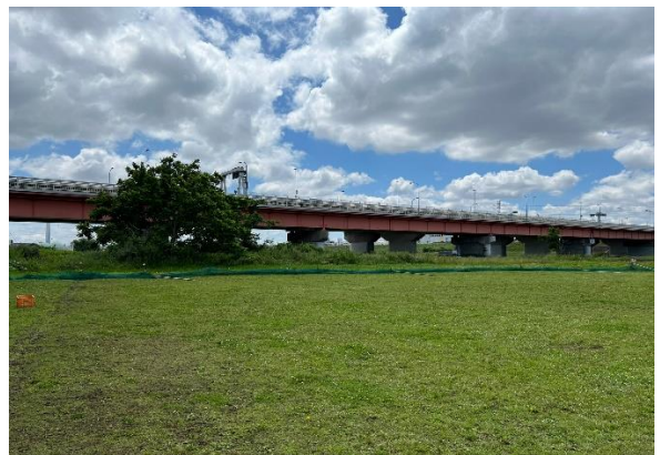
撤去作業完了
